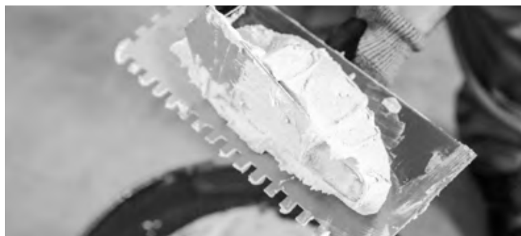
Spread the adhesive cement with a toothed trowel | Extiende el cemento de agarre con una llana dentada | Étendre le ciment à prise rapide à l'aide d'une spatule dentée | Verstreichen Sie den Klebemörtel mit einem Zahnschachtel
