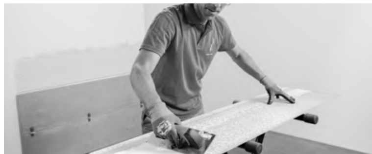
Spread the adhesive cement with a toothed trowel on the tile | Extiende el cemento de agarre con una llana dentada sobre la pieza | Étendre le ciment à prise rapide à l'aide d'une spatule dentée sur la pièce | Verstreichen Sie den Klebemörtel mit einem Zahnschachtel auf der Fliese
