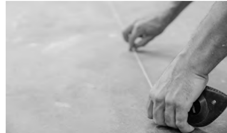
Set the guideline | Plantea la línea maestra | Établir la ligne maîtresse | Spannen Sie die Richtschnur
